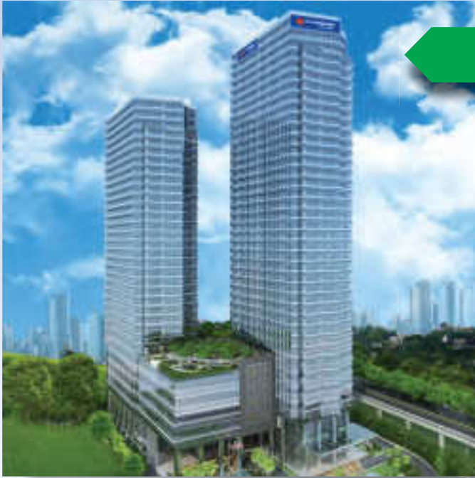
Menara Bank Rakyat, Kuala Lumpur
